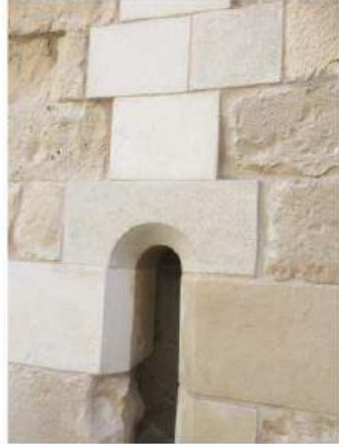
RILIEVO FOTOGRAFICO POST OPERAM
